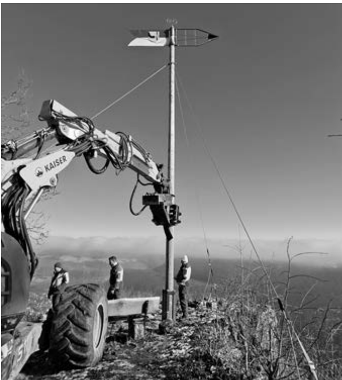
Die mit einem Schreitbagger fixierte Wetterfahne nach der Aufstellung
